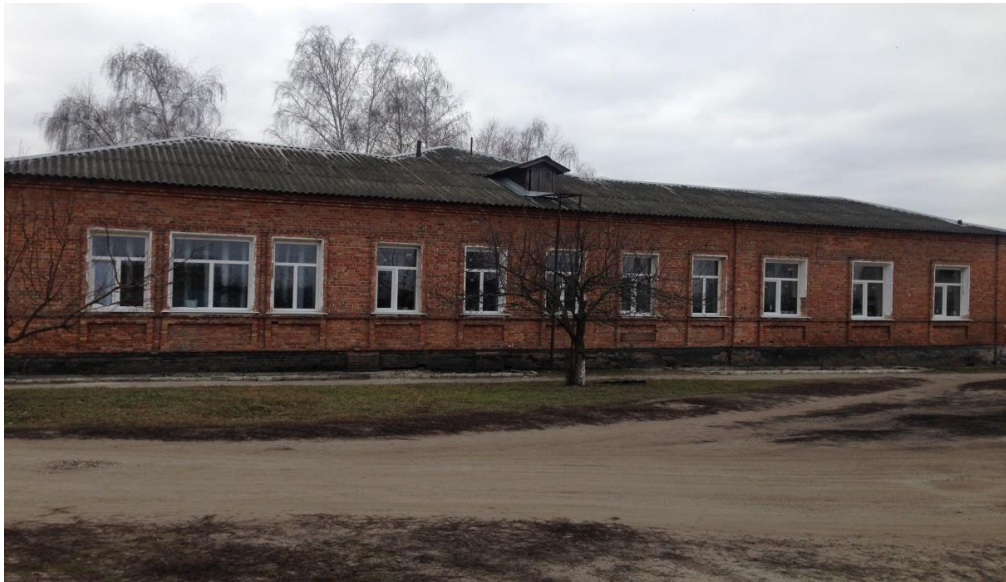
На фото приміщення адміністративного корпусу та амбулаторії ЗПСМ № м. Вовчанськ
