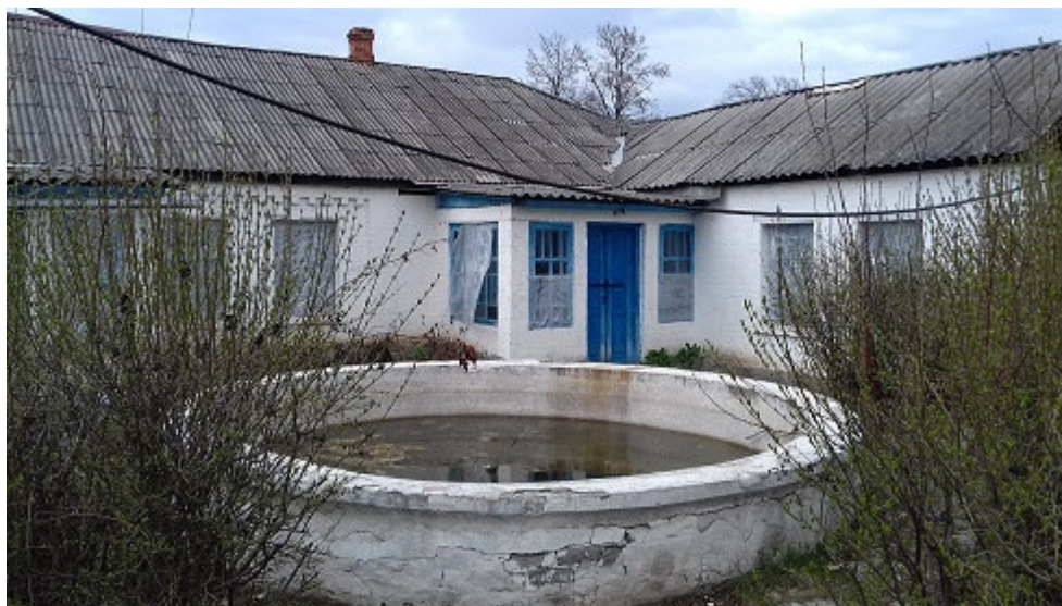
Будівля холодильного цеху
